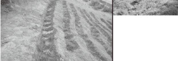
植生工。用水路の左壁面には、斜面から流れてくる雨水を用水路に取り込むために、2m間隔で穴が開けられている。斜面を植物で覆うことにより、穴が土砂で閉塞するのを防ぐことを期待する(2024年9月11日)
