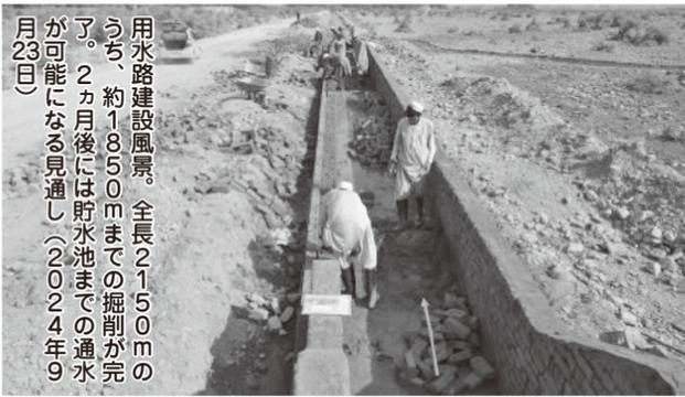
用水路建設風景。全長2150mのうち、約1850mまでの掘削が完了。2カ月後には貯水池までの通水が可能になる見通し(2024年9月23日)
