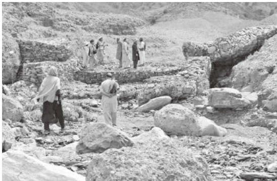
トールナウ地区で、砂防堤の建設候補地を訪れたPMS支援室と技術アドバイザー、PMSエンジニアたち。トールナウは降雨があるとしばしば鉄砲水が流れ下り、下流側の村が被害を受けていた。砂防堤を建設することで鉄砲水の緩流化を図る。以前他団体が建設した砂防堤(写真)は、勢いよく流れ下る鉄砲水によって、倒壊したまま放置されている(2024年8月21日)
