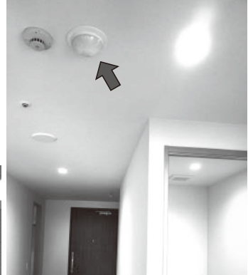
お手洗いに向かう廊下天井に設置の人感センサーは12時間人を感知しないと健康管理ステーションに自動通報する
