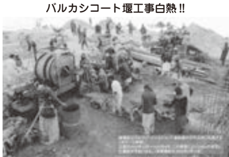
取水門基礎工事風景。掘削機でセメントと玉石を混ぜ、厚さ50cmの強靱な基礎とする（2021年1月3日）
